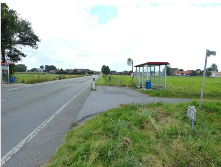
Abbildung 3-19: Haltestelle Jeggen, West in Bissendorf vor dem Ausbau.
