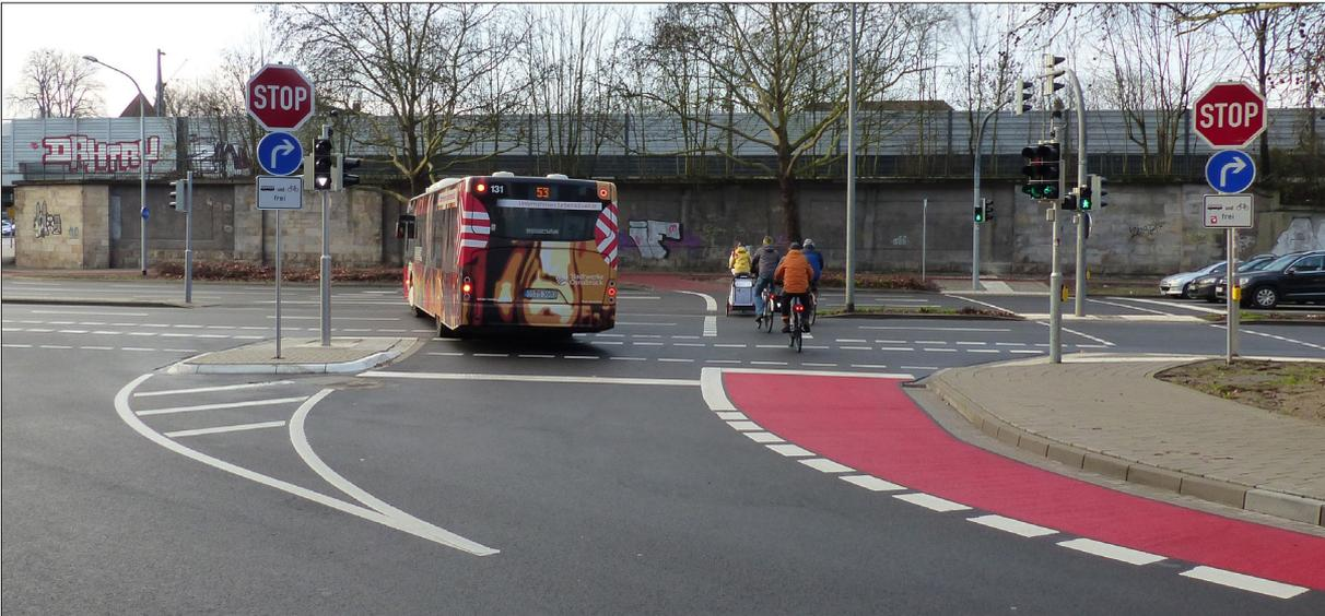
Abbildung 3-23: Beispiel zur Busbeschleunigung an der Kreuzung Bramscher Straße/Hansastraße in Osnabrück.
