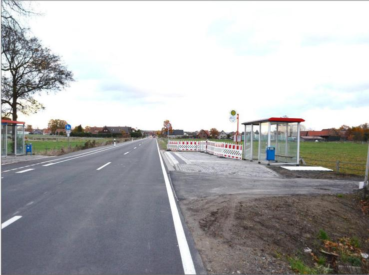
Abbildung 3-20: Haltestellen Jegggen, West in Bissendorf nach dem Ausbau als Beispiel für eine Straßenrandhaltestelle.
