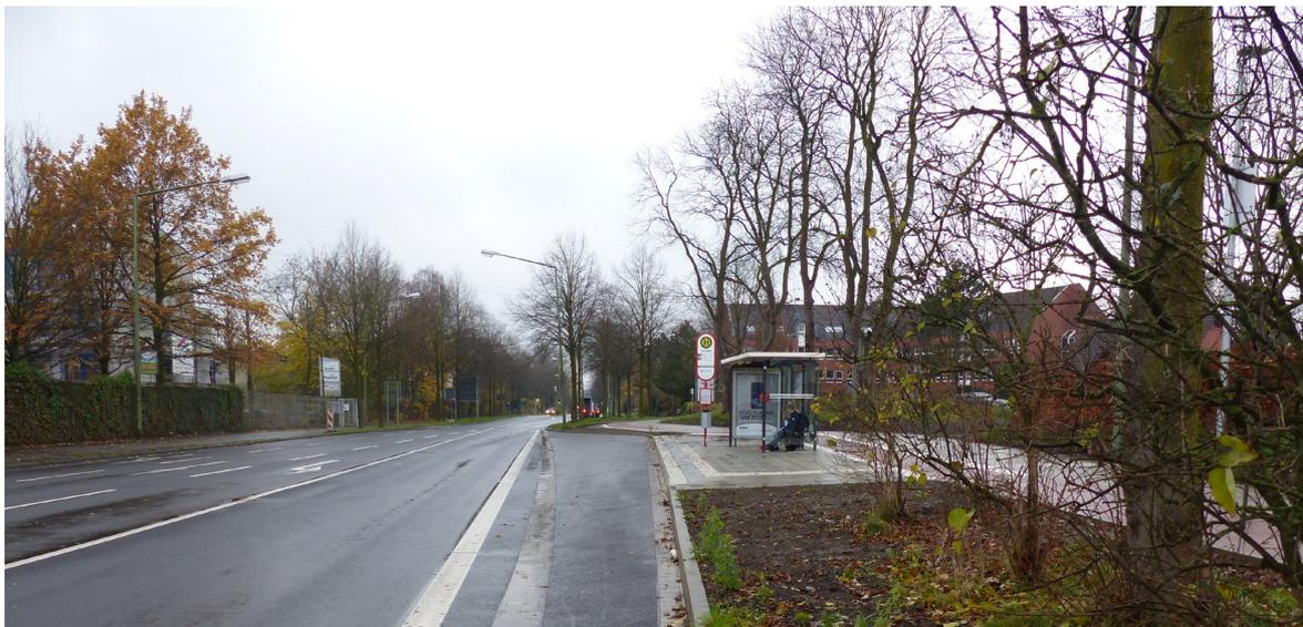
Abbildung 3-21: Haltestellen Zur Spitze in Osnabrück-Hellern als Beispiel für eine Busbucht nach dem Sägezahn-Prinzip.
